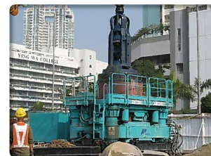
地中障害物切削
