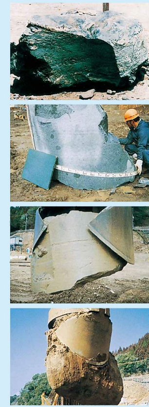
転石の切削・排削例
