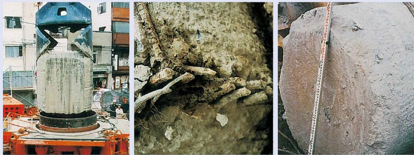
▲掘り出された鉄筋コンクリート基礎
