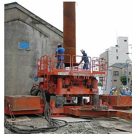
RT-150LIIによる鋼管杭施工状況
