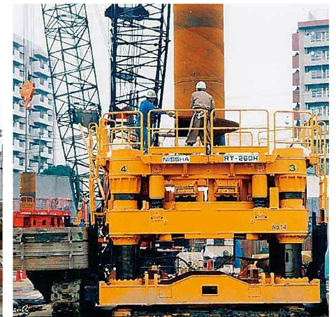
RT-260Hによる鋼管杭施工状況
