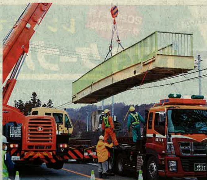
分解した歩道橋を搬出する作業員ら —北杜市白州町下教来石
