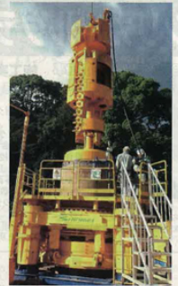
写真 施工状況
